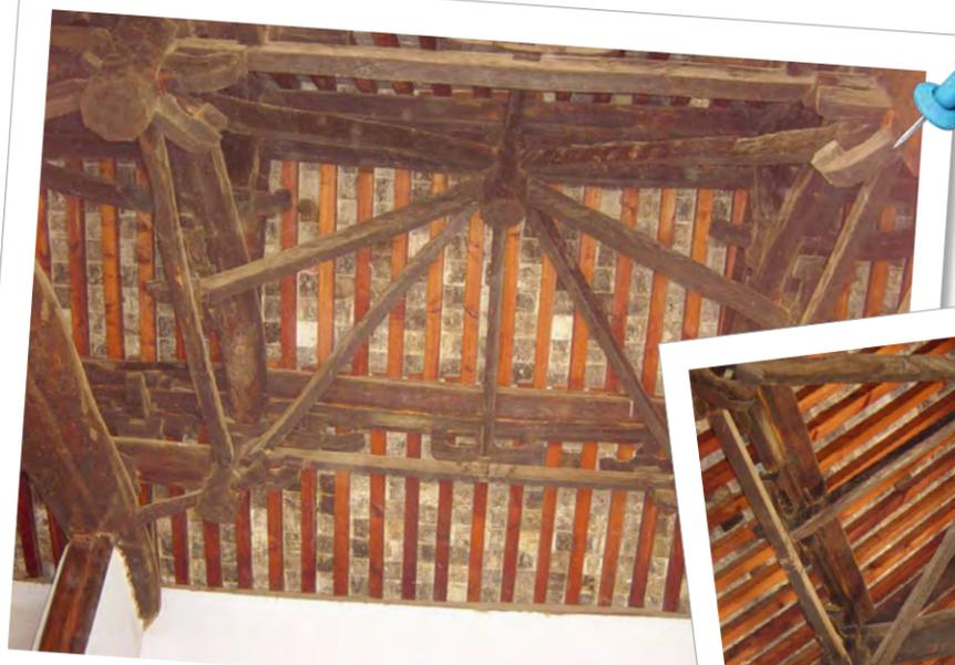
▲颜子庙大殿二梁不在大梁上的梁架结构
